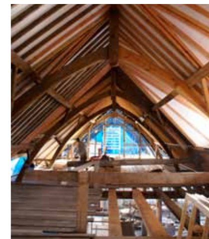
De oude sporenkap met rondspanten in ere hersteld
