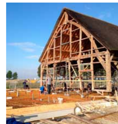
Achterzijde van de boerderij met de vloer van de uitbreiding vlak voor de stort
